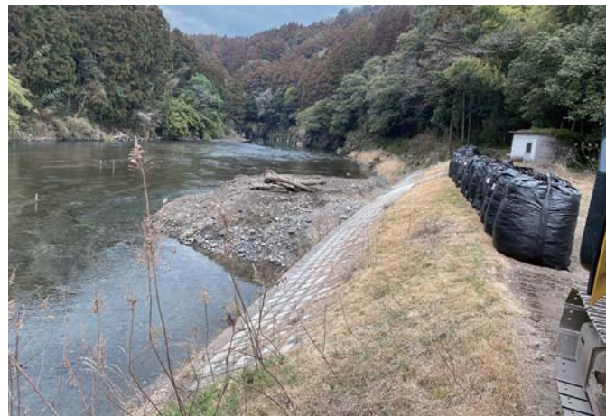
【串良川】 災害復旧と寄り洲除去
